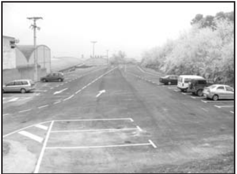
- Un aparcamiento muy cercano a las calles Cavas, Grande, Mártires y Raso -
